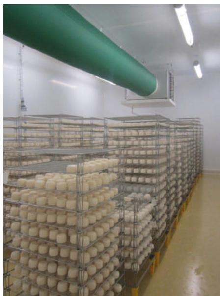
*Conditionneur d'air ventilé situé au plafond, nettoyable manuellement au canon à mousse.*
