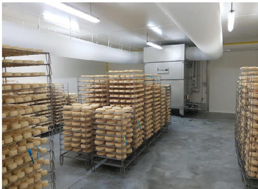
*Conditionneur d'air ventilé situé au sol, nettoyable en automatique avec un système embarqué.*
